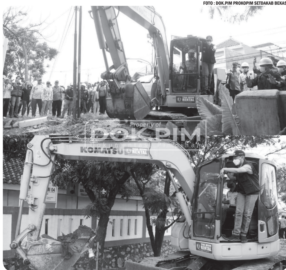
Pj. Bupati Bekasi, Dani Ramdan (di atas excavator) saat meninjau perbaikan jalan di SDN Sukadami 04, Cikarang Selatan, Kamis (26/5).
